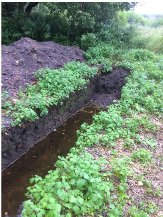
Grøft K, eget foto.
