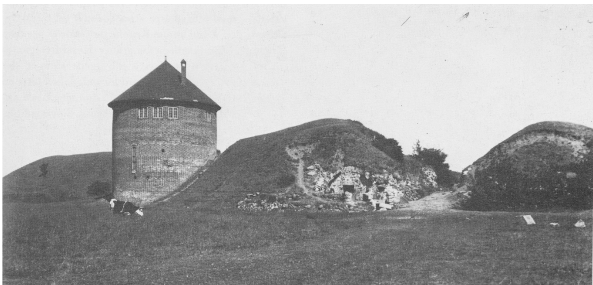
Fra angrebssiden har tårnet rejst sig med tre synlige etager over voldgraven. På fotograf Thomas Pedersens optagelse fra 1922 er området foran voldene helt opfyldt. Ved undersøgelserne 1979-80 blev graven genskabt og de besøgende må nu - som på bisp Jørgen Friis' tid - betragte tårnet på behørig afstand, se fig. 40. Hikuin 19, 1992, s. 243.
