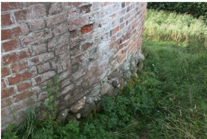
Kampestensfundamentet under tårnet, formodes at være oprindeligt. Eget foto 24.8.2016.
