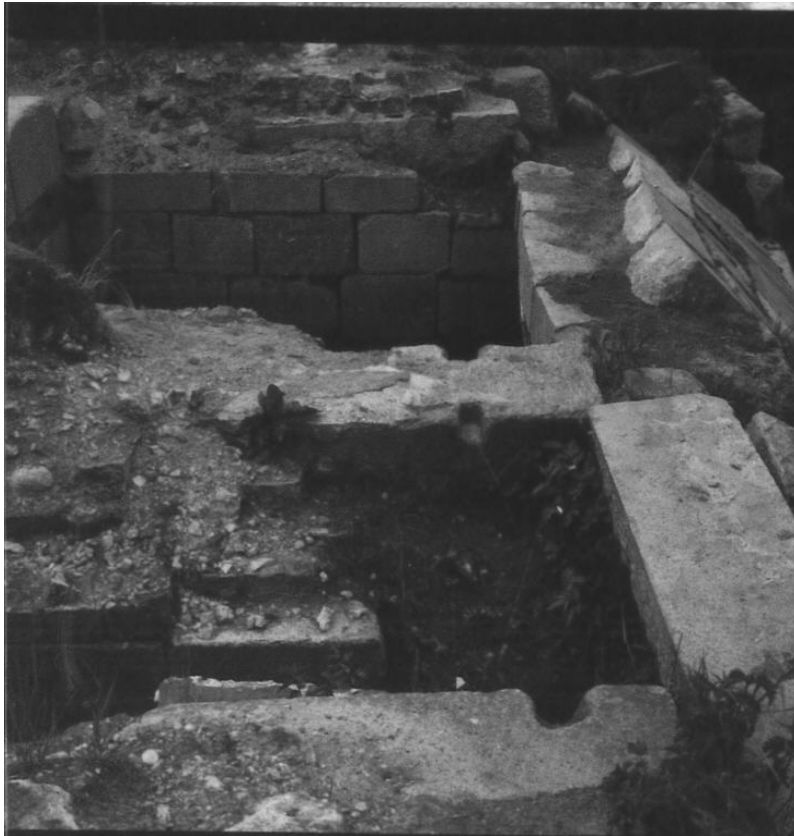
Foto 19: Set fra nord. Forrest lille vindebros kontravægtsgrube, herefter skillevæggen mellem gruberne og bagerst store kontravægtsgrube. Bemærk lejefordybningen i den forreste kvadersten og fordybningerne i skillevæggen. Bemærk, at lejefordybningerne ikke ligger på linje. Alt tyder på, at den nordlige lejekvadder til lille vindebrogruber er blevet forskubbet på et tidspunkt. Bemærk også det skrå glacis til højre i billedet, øverst.
