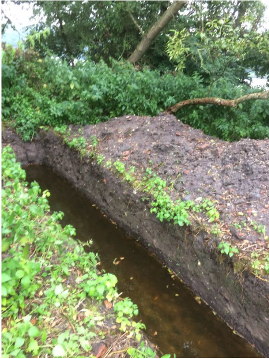
Grøft K, eget foto.
