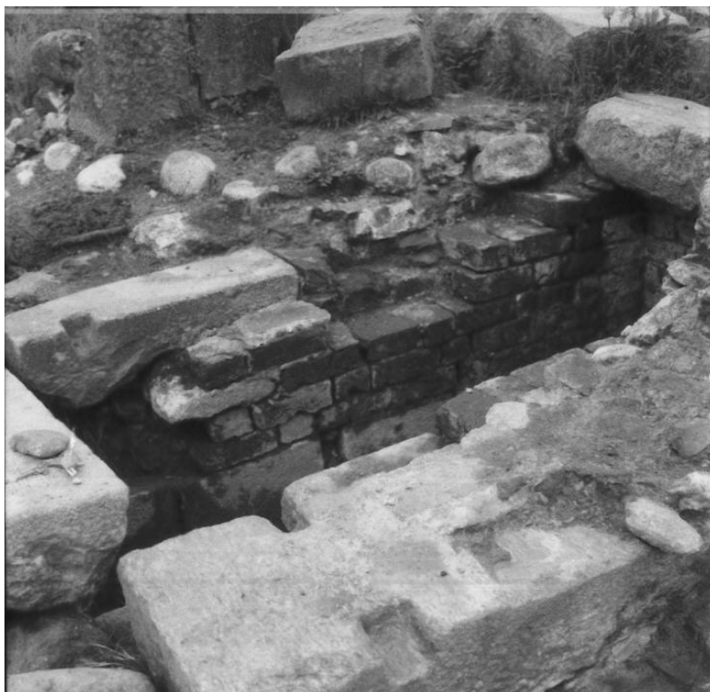
Foto 16: Lille kontravægtsgrube set fra sydvest. Forrest ses skillevæggen mellem store og lille vindebros kontravægtsgrube. Bemærk lejefordybningerne i de 2 kvadersten.
