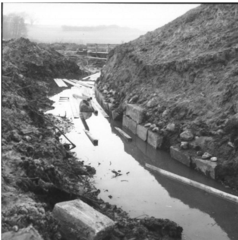
Foto 8: Kvaderstensfronten set fra syd. Bemærk den midlertidige arbejdsbro over den udgravede voldgrav. Bemærk også, at en del af kvadrene mangler/er fjernet, hvilket indikerer, at fronten efterfølgende blev restaureret af Hertz. Dette nævnes også af Niels Junggreen Have ved telefonsamtale i oktober 2016. En enkelt kvader ligger tilsyneladende i vandet en anden på brinken på modsatte side, forrest i billedet.
