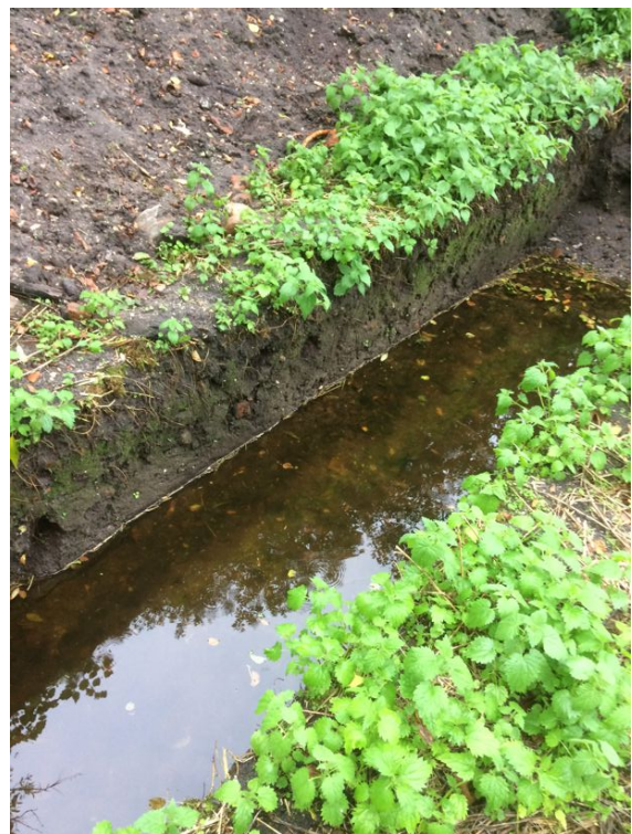
Grøft K, eget foto.
