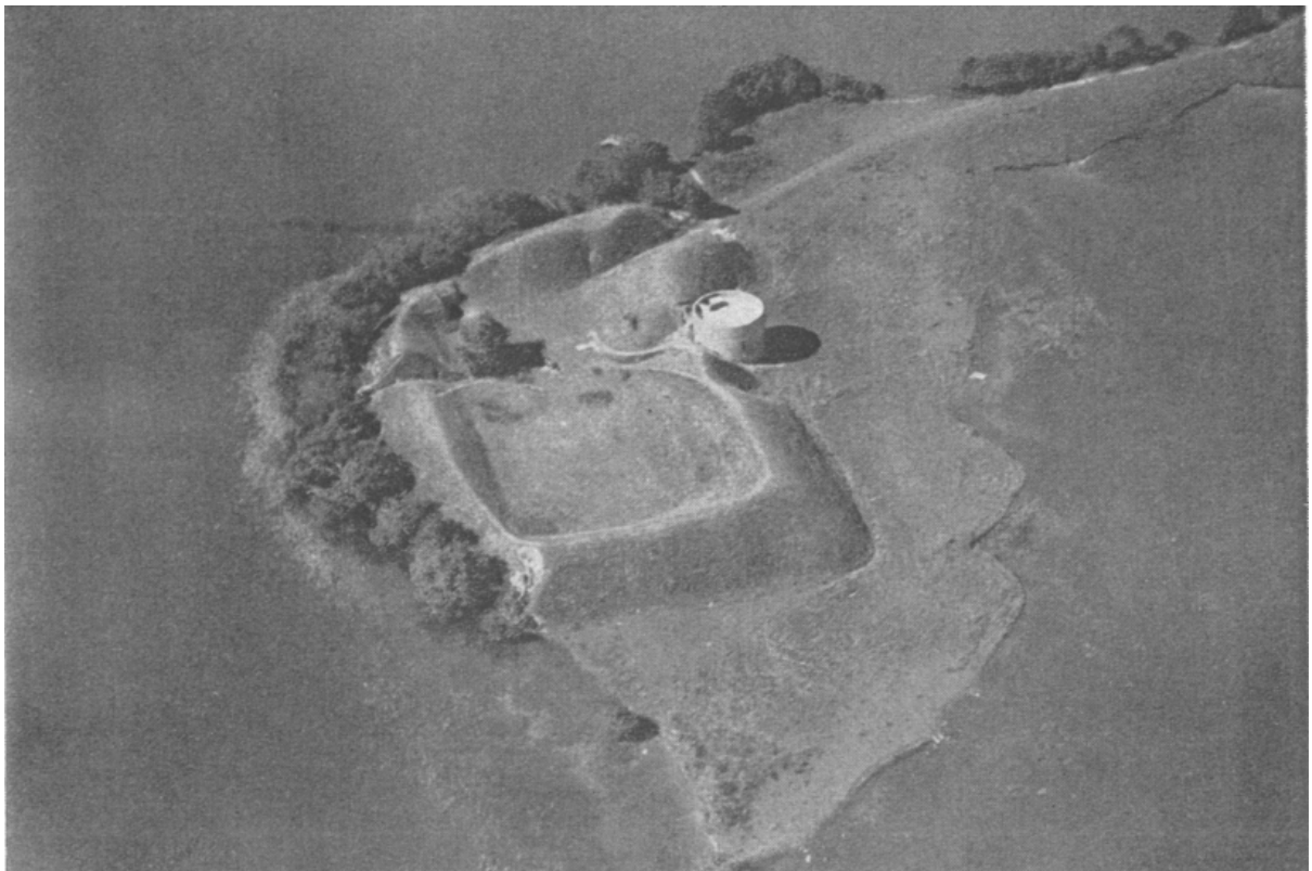
Luftfoto set fra nordøst. Langs adgangsvejen ind til portbygningen er der (2016) vandfyldt grøft på begge sider, vejen ligger på en dæmning,. Da billedet blev taget eksisterede sådanne grøfter ikke.
