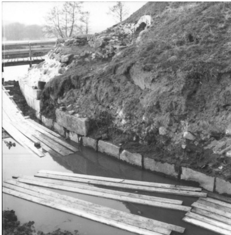
Foto 10: Kvaderstensfronten set fra syd. Bemærk den midlertidige arbejdsbro over den udgravede voldgrav. Bag granitkvadrene anes en pakstensmur.
