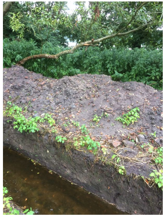
Grøft K, eget foto.
