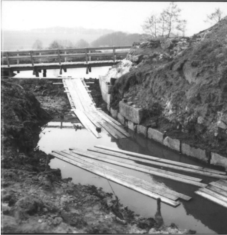
Foto 9: Kvaderstensfronten set fra syd. Bemærk den midlertidige arbejdsbro over den udgravede voldgrav.
