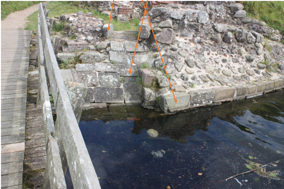
Eget foto 24.8.2016. Glaciet ved vindebroen, samme sted som fotoet ovenover. Det synes klart, at den profilerede kvader og kvadren herover nu er forsvundet. Det kunne være sket ved Hertz's udgravning og delvise omsætning af fronten 1979-80. Vandspejlet i Hald Sø på foto 0044 skønnes af hensyn til Non Mølle fortsat at ligge omkring kote 9,13 DNN.
