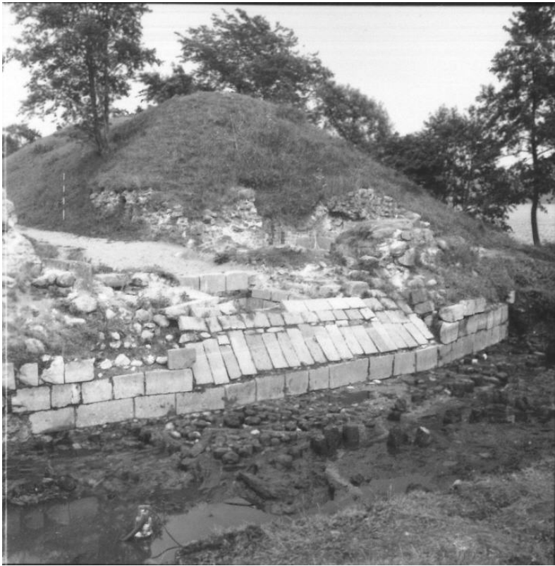
Foto 1: Kvaderstensfronten set fra nordvest. Bemærk pælene i søbunden udenfor granitfronten. De er formodentlig en del af en pælefundering i et slyngværk til fundering af granitfronten.
