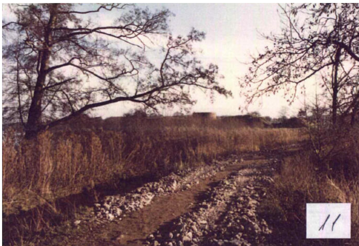
Brokker fra nedbrydningen udlagt på dæmningen.
