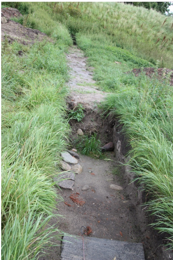
Søgegrøft 2, afslutning af bordurstensbelægningen ved punkt d, set mod nord. Eget foto.
