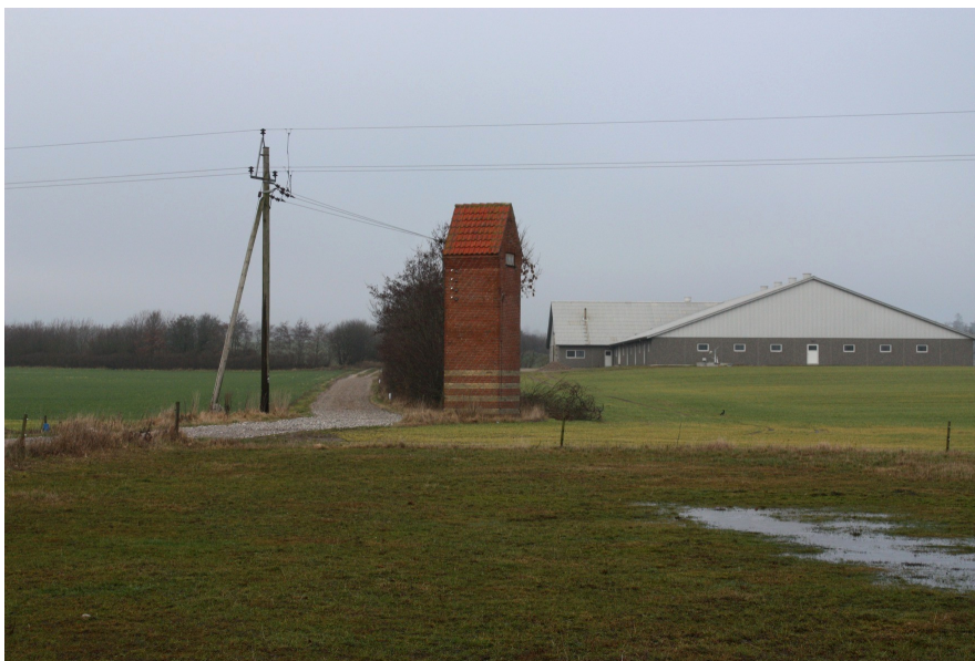
Figur 106: Transformortårn nord for Gelstrup, eget foto 2009.
